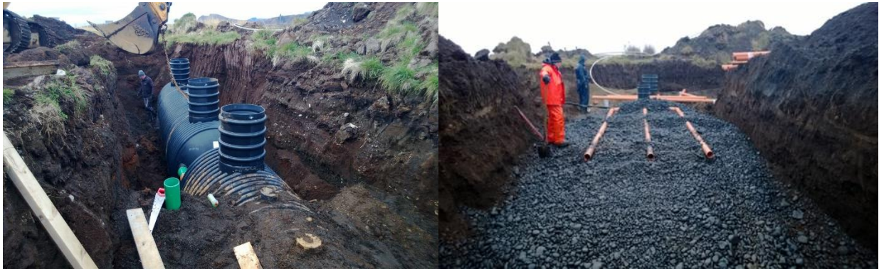
Framkvæmdir við nýtt fráveitumannvirki, rotþró og siturlögn.
